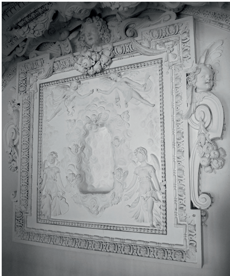
Štuková dekorace čelní stěny kaple s edikulou a figurami andělů (foto František Zelinka)
