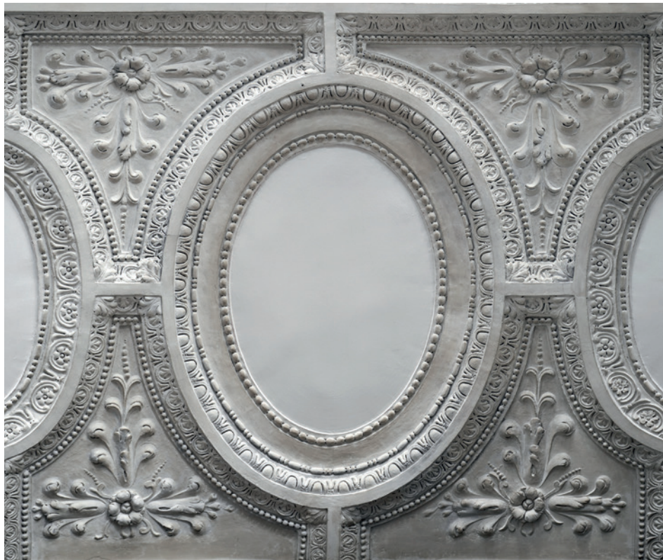
Fotografie klenby výklenku mezi Sálem předků a Nástupním sálem s manýristickým štukovým dekorem (foto František Zelinka)
