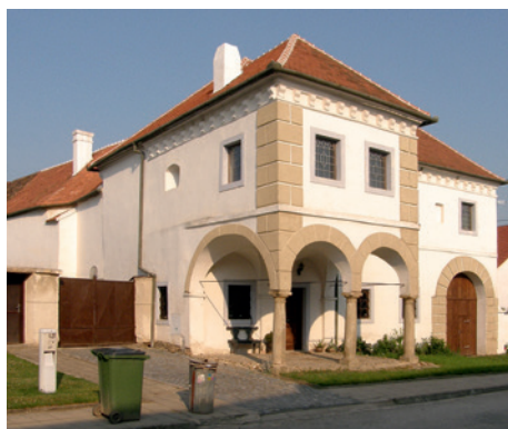
Dům č. p. 115 se žudrem v Pouzdřanech (foto Pavel Borský, 2017)
