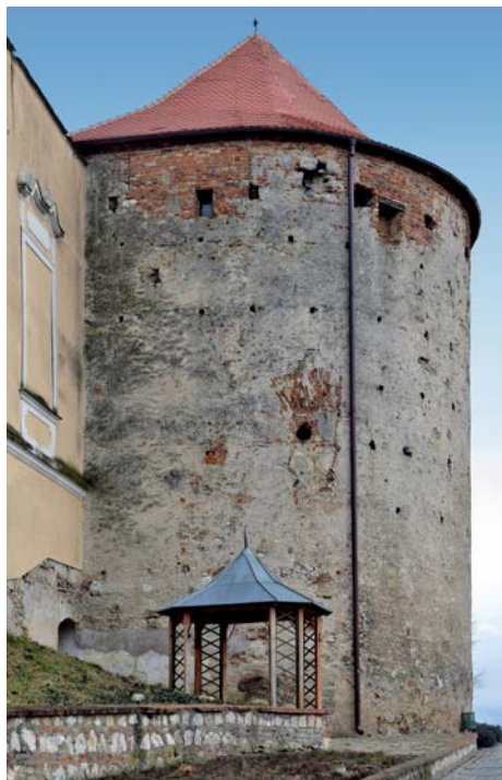
Udírenská bašta od severu. V místě altánu při patě věže se nacházela přistavěná barokní kuchyně. V úrovni patra je torzo větší klíčové střílny. (foto Pavel Borský, 2019)
