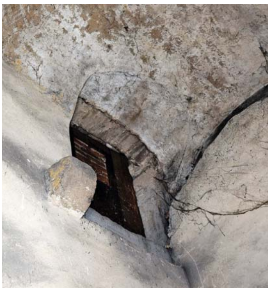
Zrušený středověký vstup do patra věže ze strany předhradí. Vstup vedl z předpokládaného vnitřního ochozu hradby, s nímž zřejmě souvisel krakorec v úrovni prahu. Nyní se zazděný vstup nachází pod klenbou přistavěné barokní schodišťové chodby. (foto Pavel Borský, 2019)
