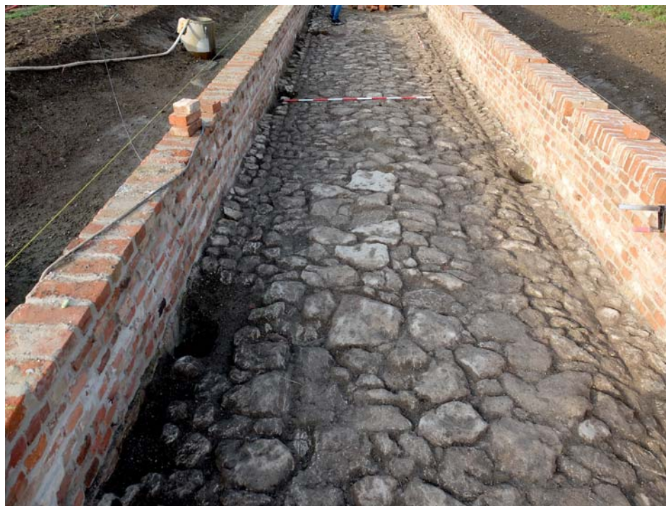
Začištěný úsek dlažby ve středové části mostu, pohled od jihu (foto Petr Holub)
