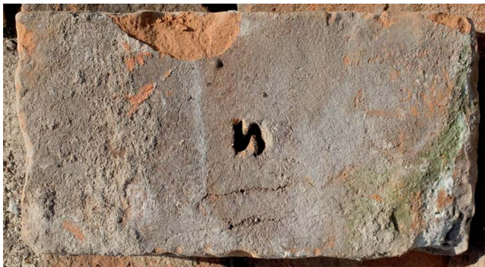
Různé druhy cihel s kolkem „N“ z původní konstrukce mostu (foto Petr Holub)
