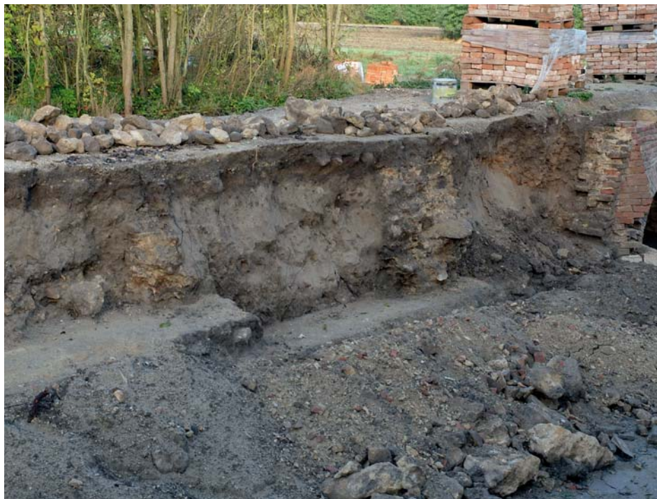
Sonda S12 s řezem P2, poskytujícím pohled do vnitřní konstrukce náběhu mostu (foto Petr Holub)
