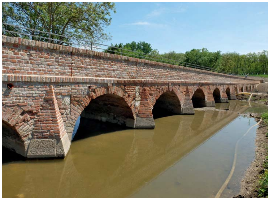
Celkový pohled na most vedoucí k ostrovu Portz po dokončení jeho obnovy (foto Petr Holub)
