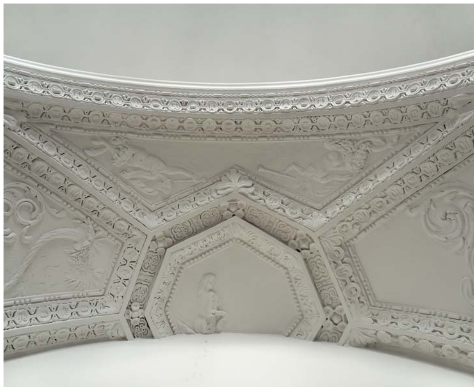
Pohled na strop výklenku (foto František Zelinka)
