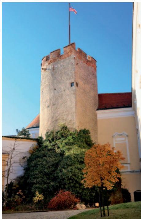
Břítová věž na bývalém předhradí se zdvojenou střílnou u břitu, který je natočený k severu ve směru předpokládaného útoku (foto Milan Karásek)
