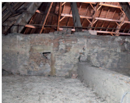
Podkroví severního křídla zámku. Zazděný otvor na severozápadní straně severního rondelu v úrovni nynějšího podkroví křídla. Jednalo se o další dělovou komoru určenou k postřelování severozápadního sektoru před pevností. (foto Pavel Borský, 2019)
