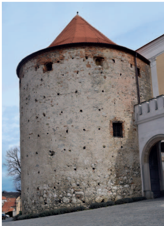
Udírenská bašta v pohledu od severu. Pod střechou jsou patrné dozděné proluky cimbuří a jediná v celistvosti dochovaná kamenná klíčová střílna osazená v poprsní proluky. (foto Pavel Borský 2019)
