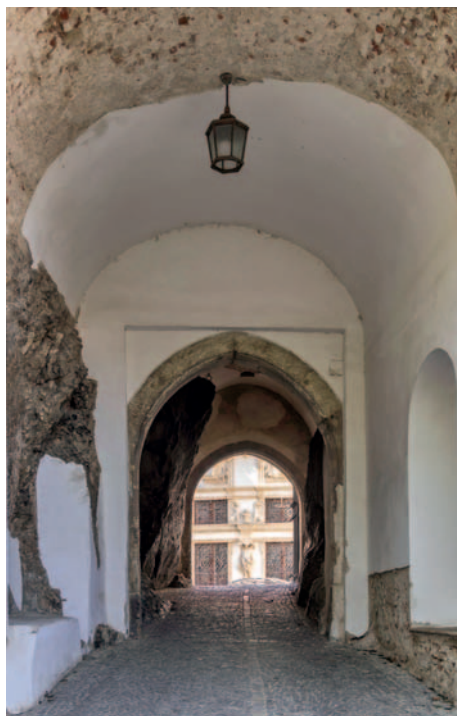
Vnější portál Skalní brány. Pravoúhlá vpadlina byla možná určena pro středověkou mříž nebo padací most. Rám také mohl vzniknout až při prodloužení brány o přední tunelovitou část v 18. století (foto Daniel Kamenár)
