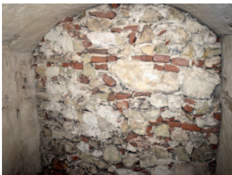
Podkroví severního křídla zámku. Detail interiéru dělové komory v horní části severního rondelu – zazdívka na straně klenby Sálu předků. (foto Pavel Borský, 2019)
