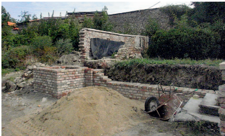
Průběh rekonstrukce památníku (foto Spolek přátel židovské kultury v Mikulově)
