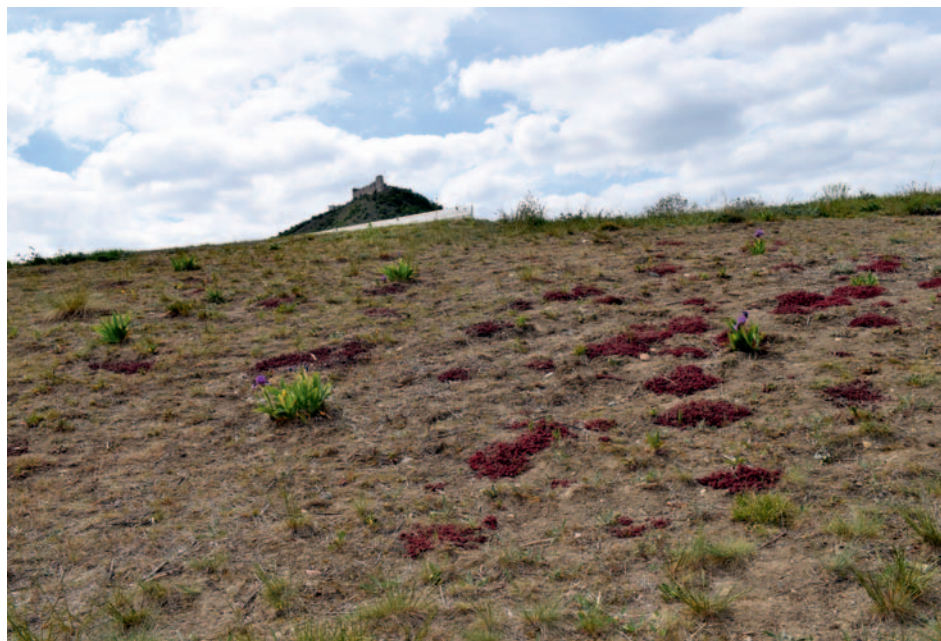
Stav střechy v dubnu 2019 po předchozím extrémně suchém roku (foto Alena Štefková)
