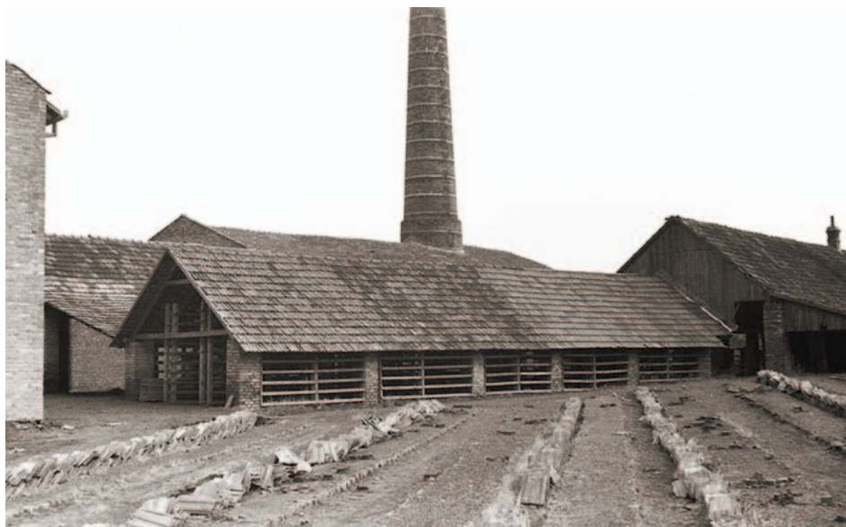
Pohled do areálu cihelny ve Velkých Bílovicích (soukromá sbírka Jaroslavy Harhajové)
