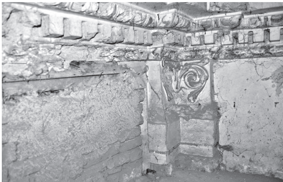
Zbytky výzdoby původního divadelního sálu, detail výzdoby (foto Miroslav Lukáš)
