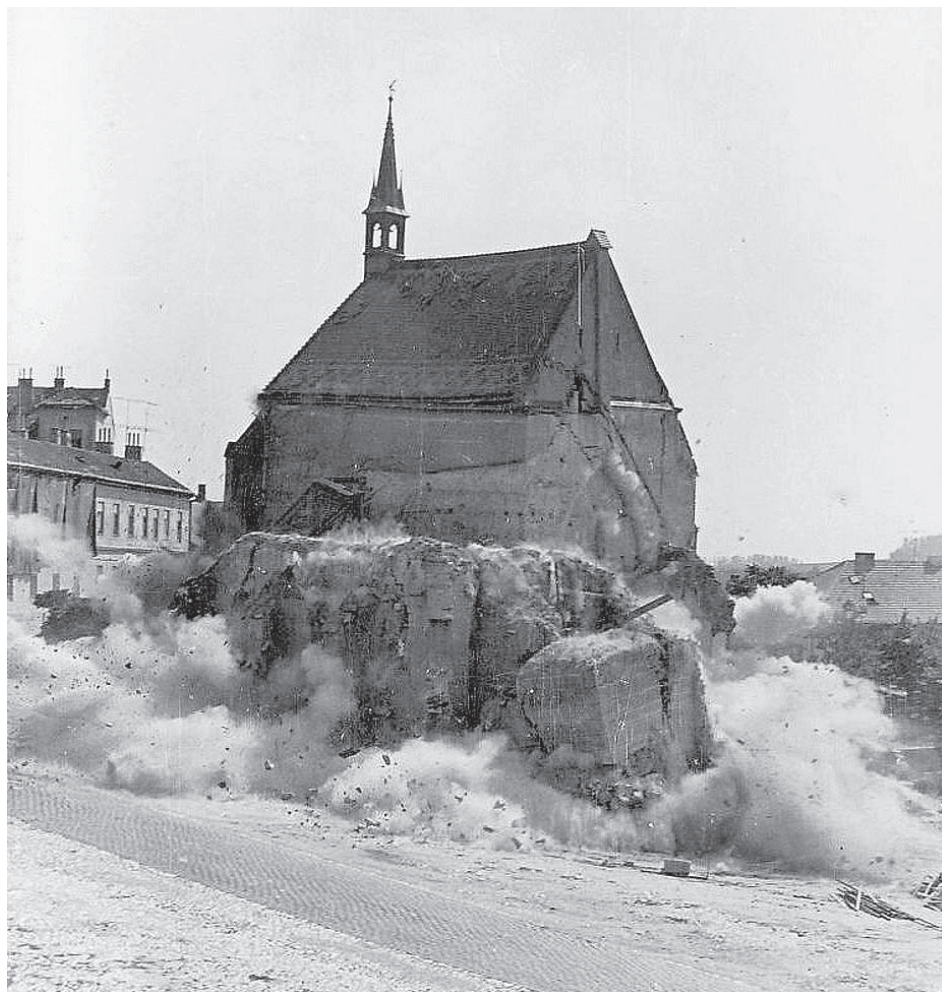
Demolice kostela sv. Václava (foto archiv MMG Hustopeče)
