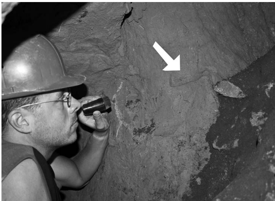
Zbytek závorové kapsy ve stěně přístupové chodby u m. b. č. 6. (foto Petr Kos)
