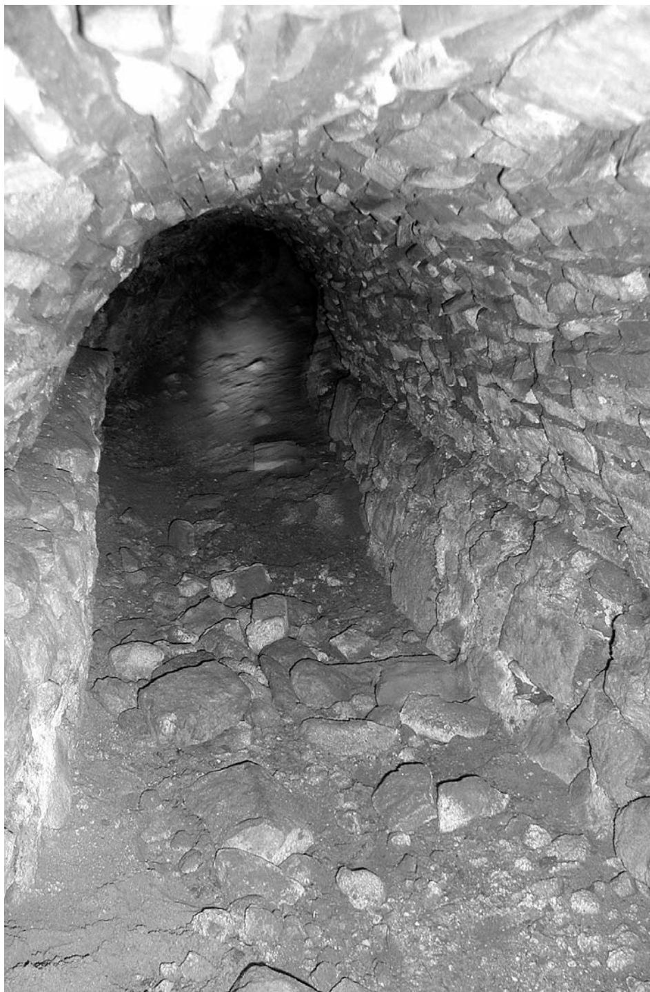
Vyzděná část podzemní chodby mezi m.b.č. 6 a 7. (foto Petr Kubín)
