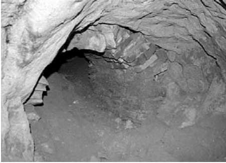
Cihelná vyzdívká koncové části chodby. (foto Petr Kubín)
