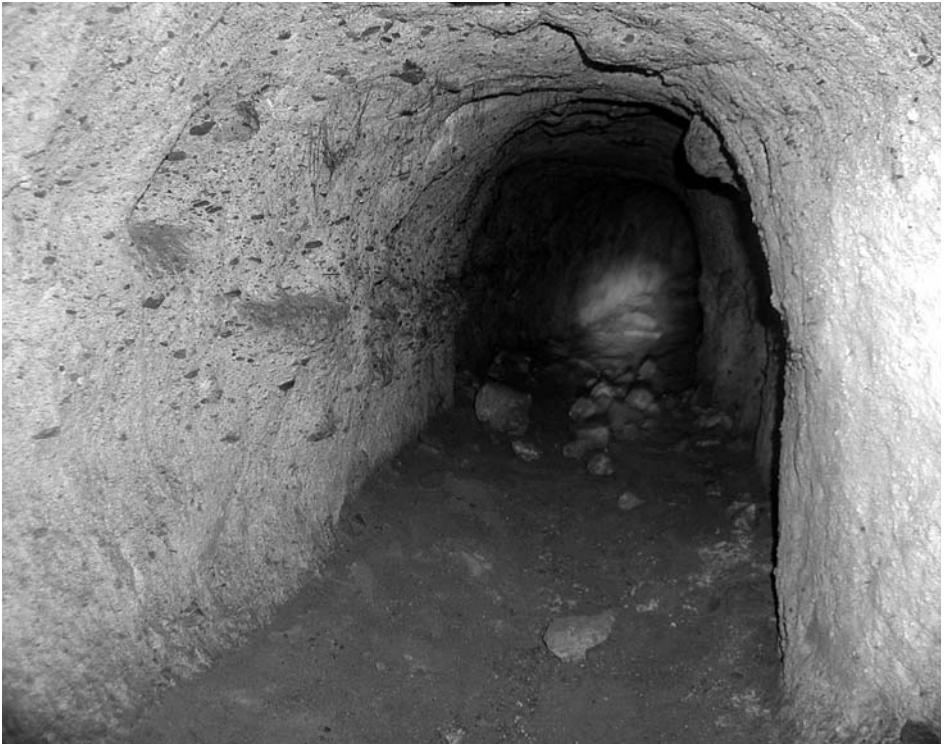
Chodba ražená v pískovcích v úseku m.b.č. 7–9. V levé stěně jsou patrný prohlubně osvětlovacích nik. (foto Petr Kubín)
