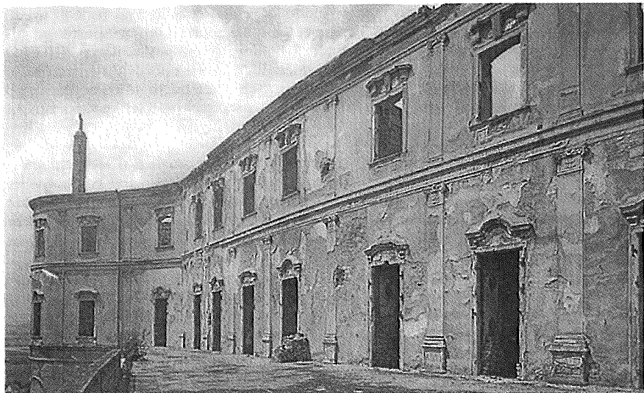
Fasáda východního křídla s velkou terasou. Na zdech jsou dobře viditelné stopy po zásazích dělostřeleckými granáty. (foto archiv RMM)
