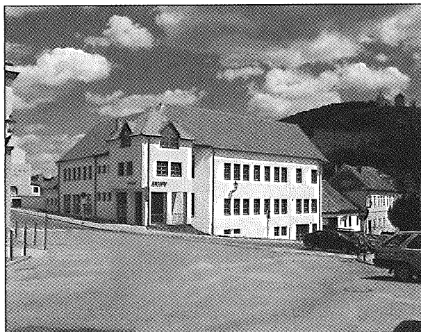
Nová budova Státního okresního archivu Břeclav se sídlem v Mikulově (foto V. Hortvík)
