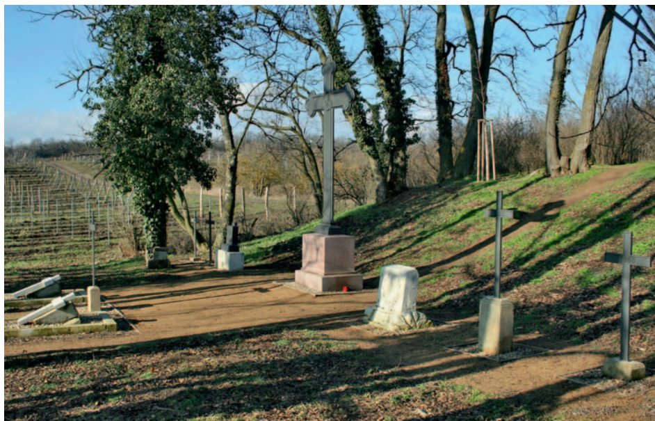
Pruský hřbitov po rekonstrukci v letech 2014–2015 (foto M. Svoboda)
