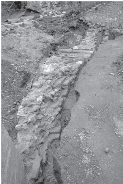
Obr. 7 – Základ pro novou kašnu s narušenou vrstvou stavebního odpadu (foto František Trampota)
