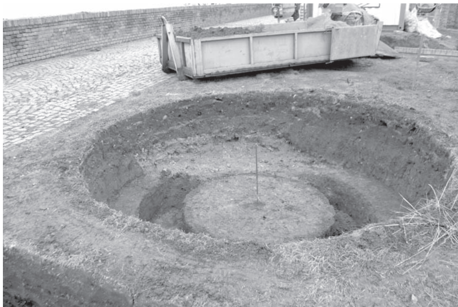
Obr. 7 – Základ pro novou kašnu s narušenou vrstvou stavebního odpadu (foto František Trampota)
