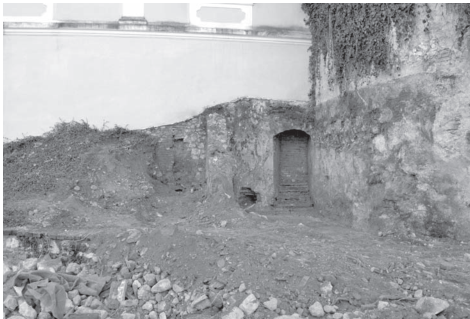
Obr. 9 – Torzo rezervní kuchyně a zazděný vstup do zámku po odstranění stavebního odpadu u Udírenské věže (foto František Trampota)
