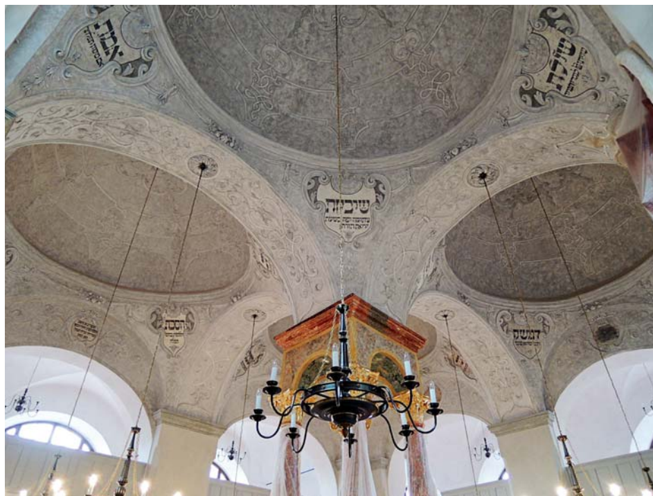
Pohled na kopulovou klenbu Staré synagogy v Mikulově po dokončení revitalizace a restaurování v roce 2014 (foto Arno Pařík)
