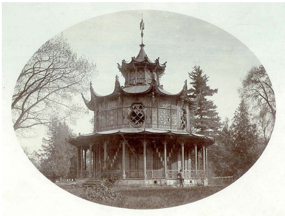
Dezolátní stav pavilonu před jeho demolicí v roce 1892 (uloženo na Státním zámku Lednice)
