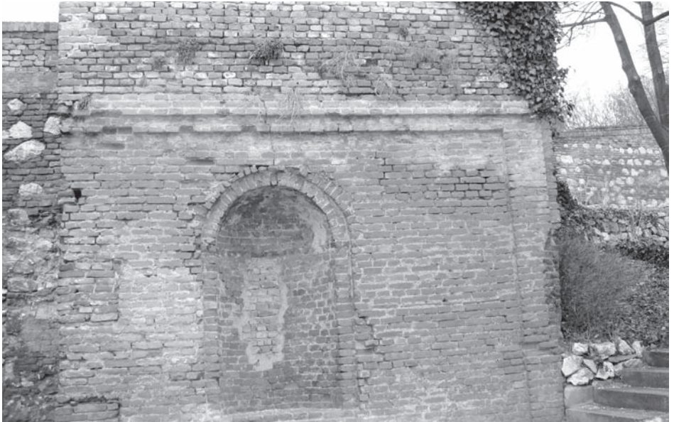
Grotta s nikou, ležící v úrovni střední terasy původního renesančního parteru před jižním zámeckým křídlem (foto Milada Rigasová)
