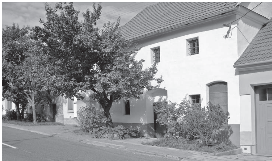
„Bendův sklep“ – vinařská stavba, již kdysi vlastnila rodina Bendova a která dnes aspiruje na zařazení mezi památkově chráněné stavby (foto Jaroslav Slezák)
