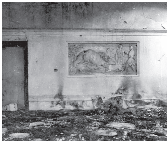
Interiér zámku po požáru v roce 1956. Reliéf - Lov na jelena (foto archiv Národního památkového ústavu, územní odborné pracoviště Brno)
