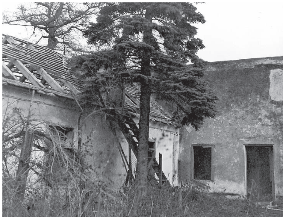
Byt hajného v roce 1956 - pravé křídlo myslivny (foto archiv Národního památkového ústavu, územní odborné pracoviště Brno)
