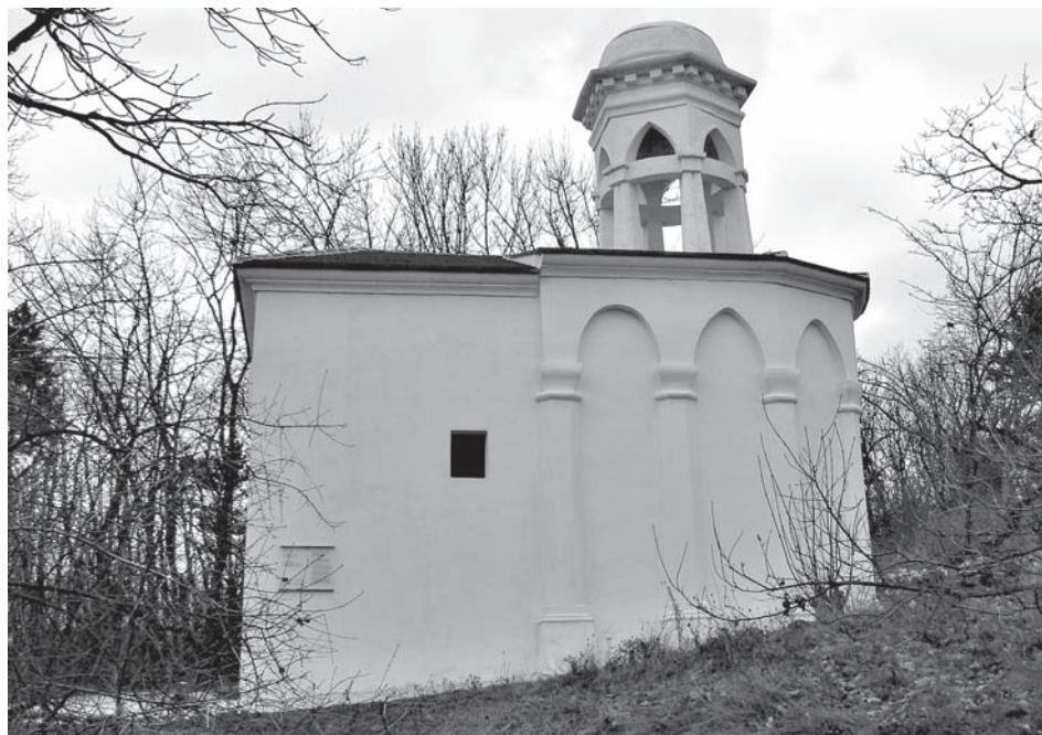
Kaple Božího hrobu po dokončení oprav; slavnostní předání a vysvěcení proběhlo 31. července 2010 (foto autor)
