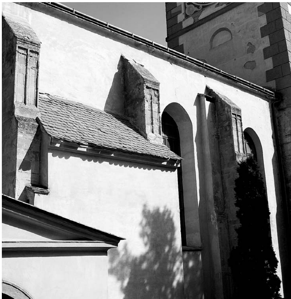
Pilíře gotického opěrného systému při jižní obvodové zdi trojlodí mikulovského kostela. (foto Milan Karásek)
