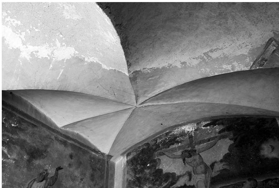
Hvězdicová klenba v předsíni krypty nacházející se pod kněžištěm mikulovského kostela. (foto Přemysl Mazal)
